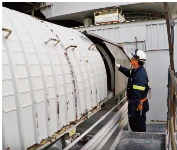
Un employé d'entretien, Dany Fortin, Manutention et captation, utilisant le nouveau panneau.
