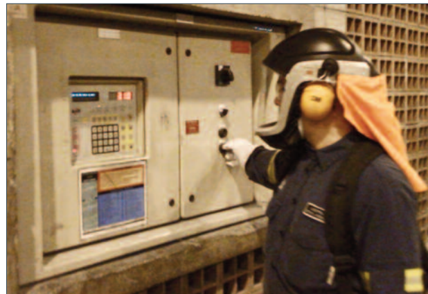
Un employé de l'Électrolyse traitant un effet d'anodes, selon la nouvelle méthode plus sécuritaire.
